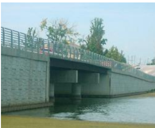
Olio Bridge (USA)
