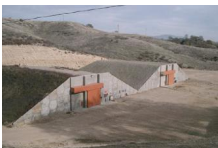
Ammunition shelters (USA)
