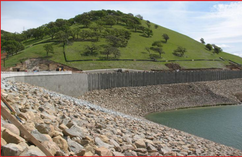
Los Vaqueros dam, California, USA
