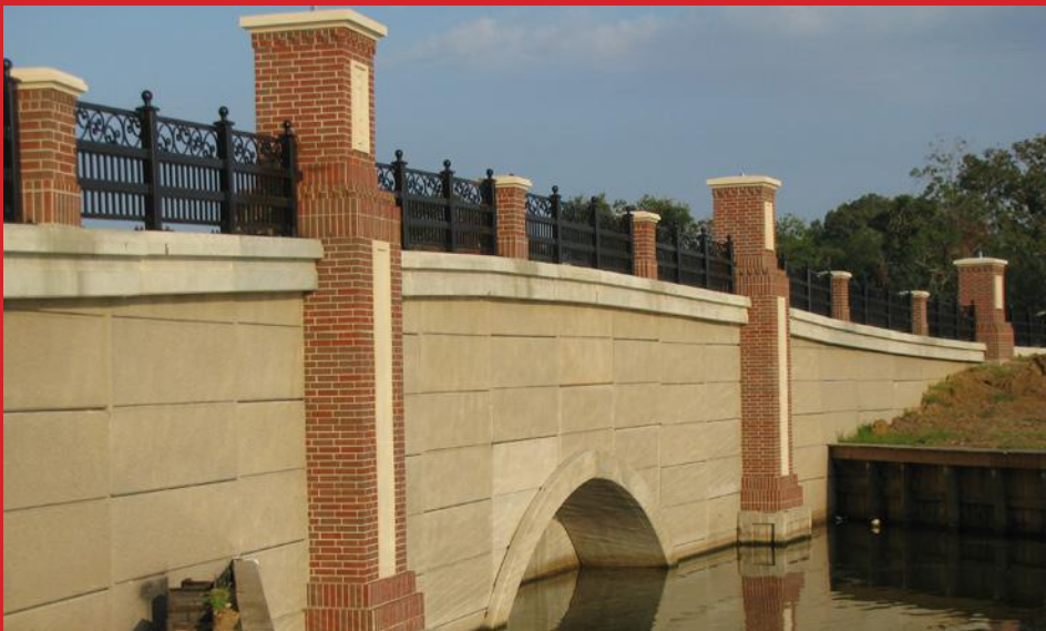
Beacon Island, Texas, USA
