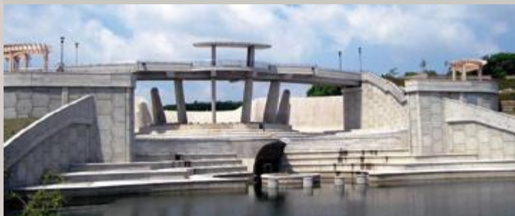
Lake Lenexa Dam, Kansas, USA
